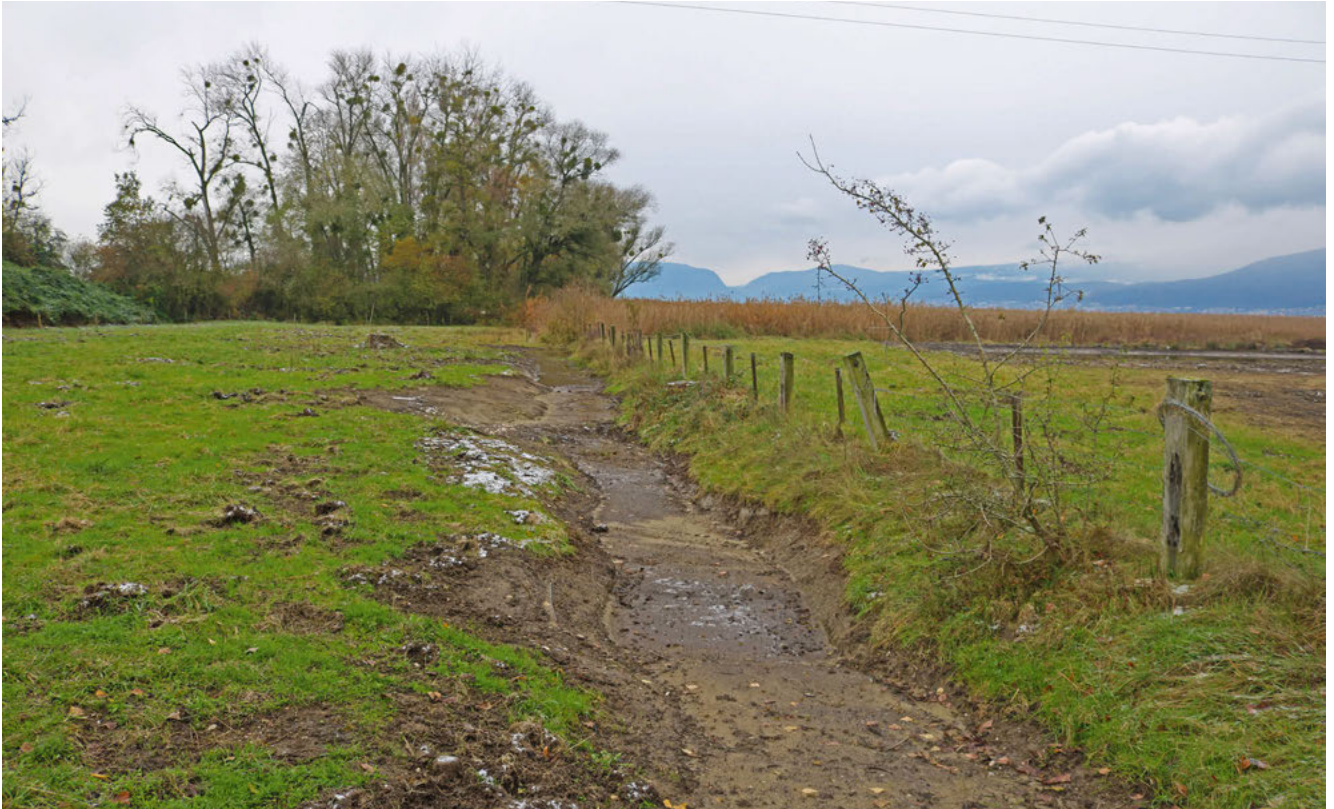
Restauration d'un fossé soumis aux fluctuations du niveau du lac. (Photo Olivier Bessire)
