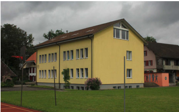
Ungeeignete Gebäude für freihängende Fledermäuse: ausgebauter Dachstock links oder Flachdach rechts. (Fotos: Livio Rey)
