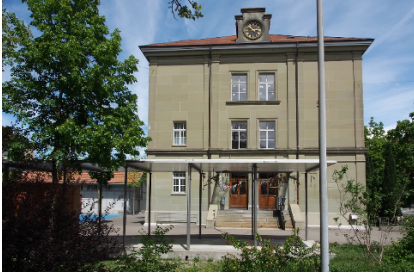
Abb. 6: Schulhaus Breitenrain. Ansicht Südost 29
