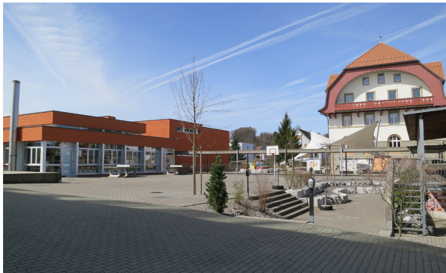
Abb. 32: Schulanlage Schmitten. Ansicht Ost
