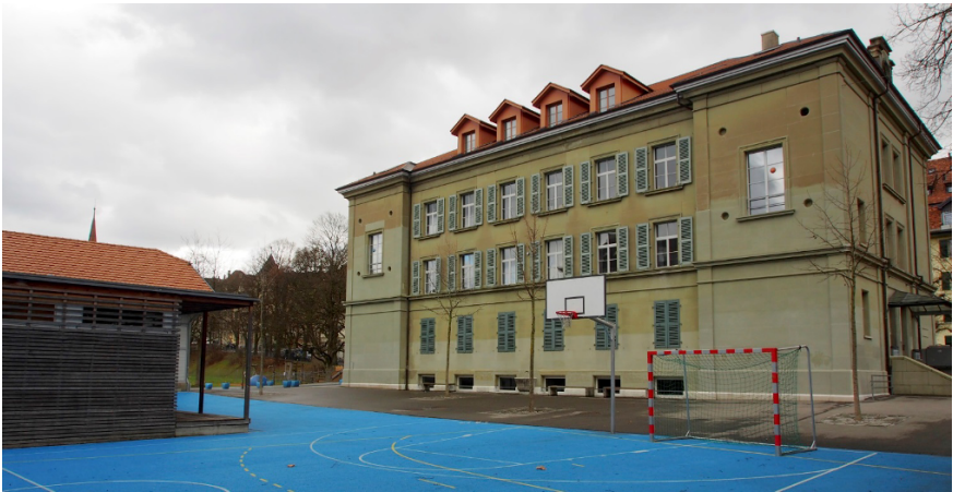
Abb. 8: Schulhaus Breitenrain. Ansicht Nord
