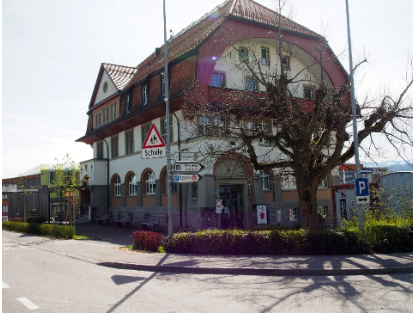
Abb. 39: Schulhaus Rot. Ansicht Nordwest
