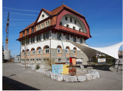
Abb. 40: Schulhaus Rot. Ansicht Südost
